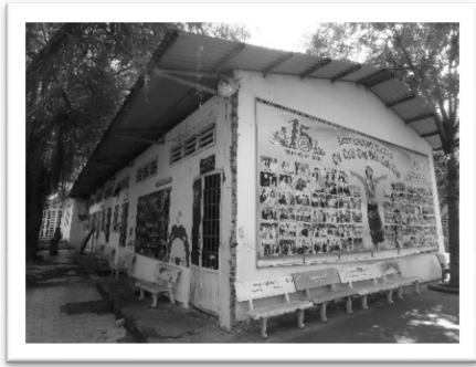
写真10：孤児院敷地内に設けられた、独立する子どものための職業訓練棟。 棟内では、自動車やバイクなどの部品を組み立てる勉強をしていた。
